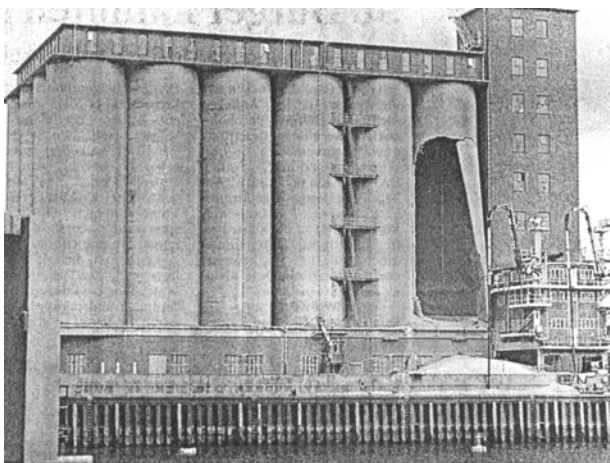
Einsturz eines Getreidesilos in Harburg, 9.7.95
