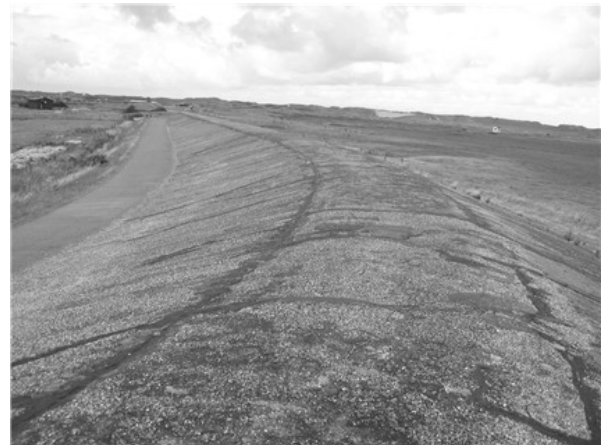
Abb. 6. Überlaufdeich bei Norddorf.
