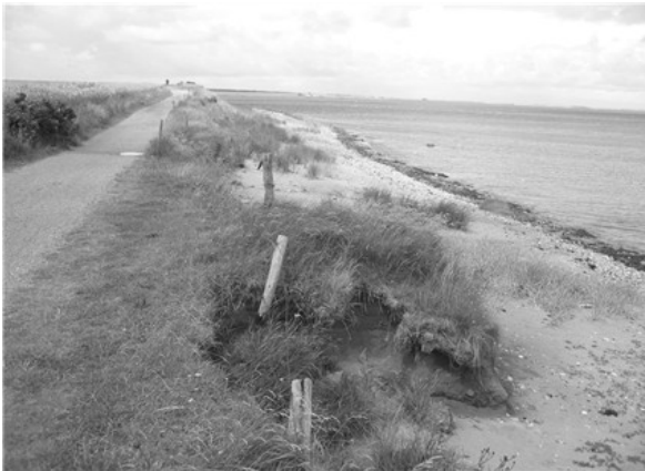
Abb. 8. Erosion an der Ostküste Amrums.
