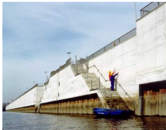
Abb. 2, Hochwasserschutz in Hamburg, Foto: LSBG
